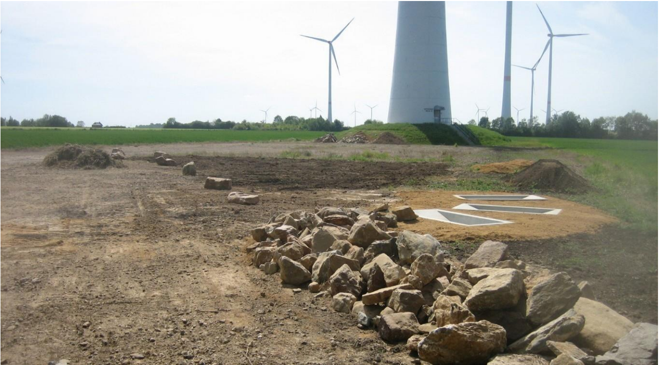
Abbildung 2: Neu angelegte Betonbecken mit Steinlinse und Sandaufschüttung entlang der WAE's
